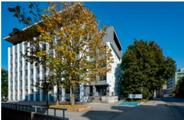
Endla tn büroohoone renoveerimine
