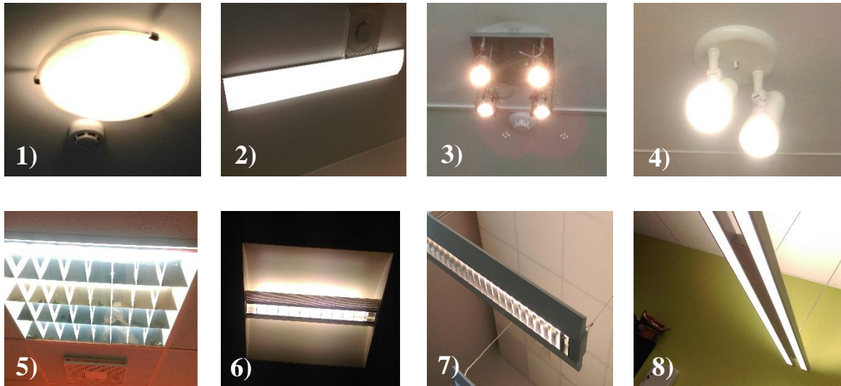
Joonis 25. Bürooruumides ja haridushoonetes kasutusel olevad valgustid: 1–4 laepinnale paigaldatavad valgustid; 5–6 lakke süvistatavad valgustid; 7–8 rippvalgustid. Kõige rohkem olid haridushoonetes ja bürooruumides levinud lakke süvistatavad valgustid. Bürooruumides oli kasutusel rohkem erineva lahendusega valgusteid nagu näiteks laepindadele paigaldatavad valgustid, rippvalgustid ning seinavalgustid.
