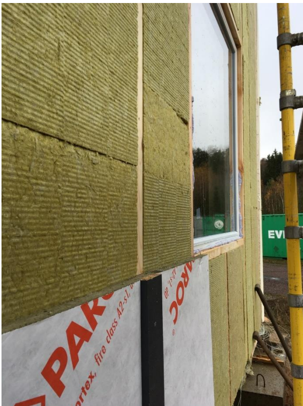
Joonis 12. Kivivill ja tuuletõke fassaadil
