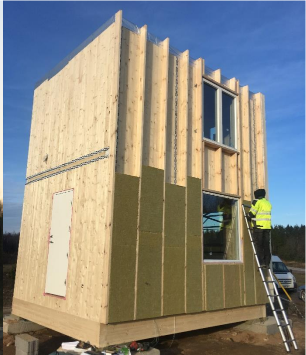
Joonis 11. Kivivilla paigaldus pikemale fassaadile
