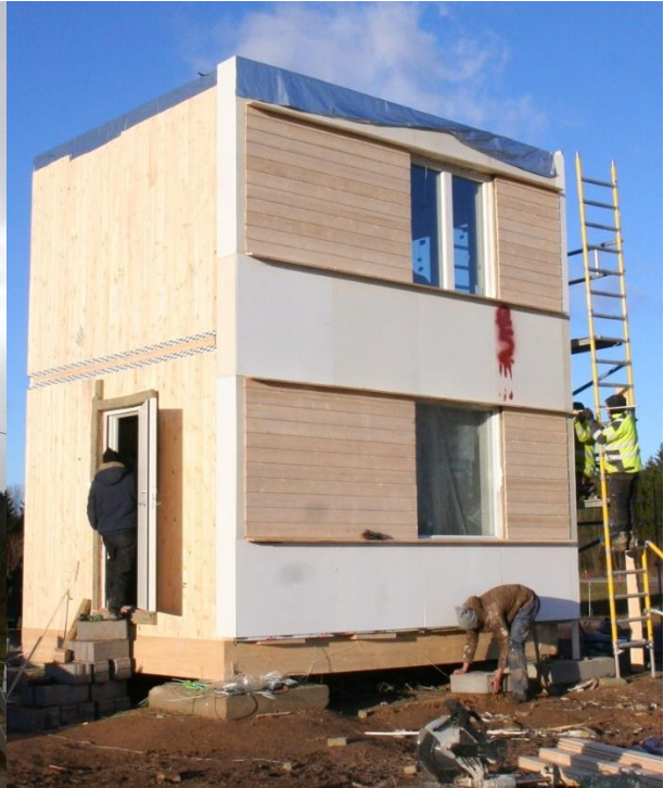
Joonis 15. Kivivillaga fassaad koos fassaadikattega (puitlaudis ja valged tsementplaadid)
