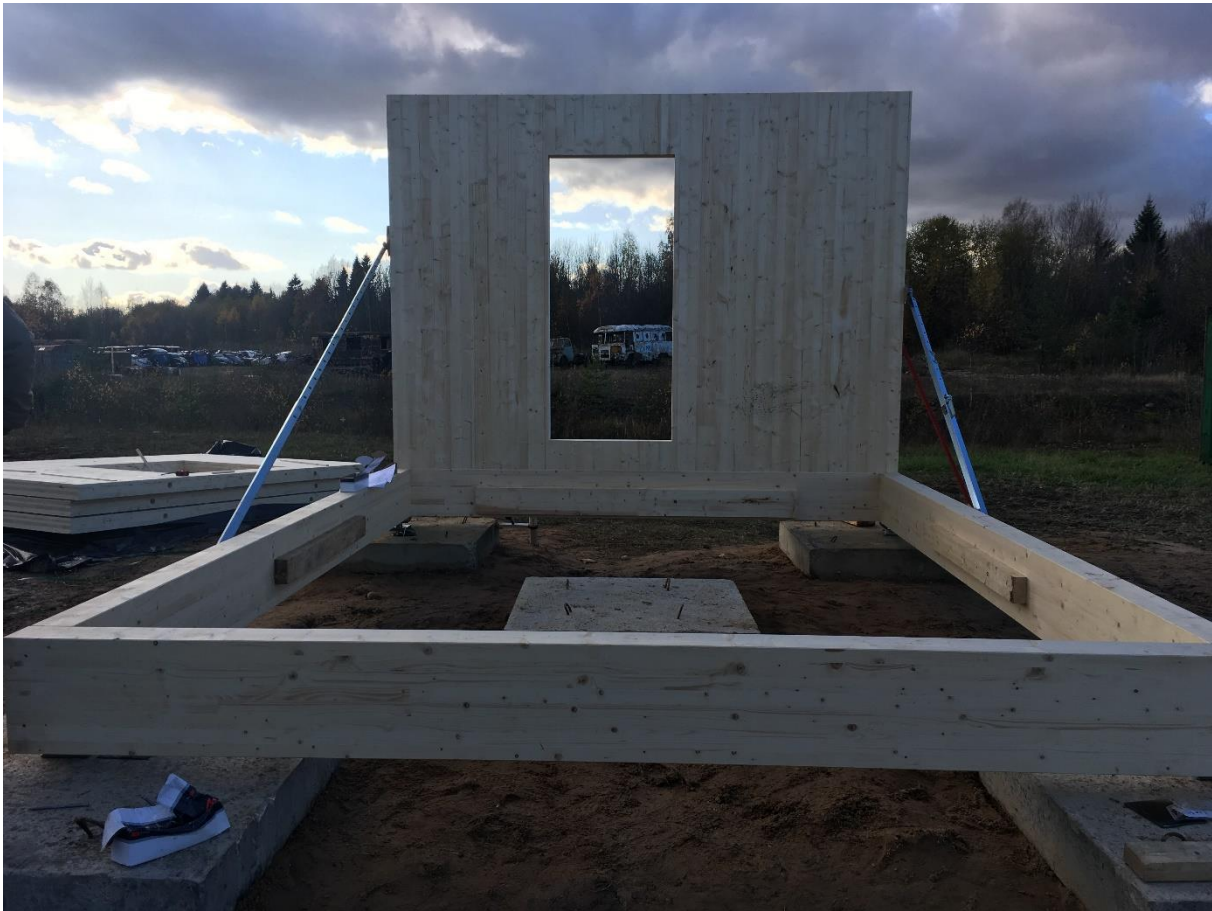
Joonis 7. Liimpuidust alusraam ja lühem sein
