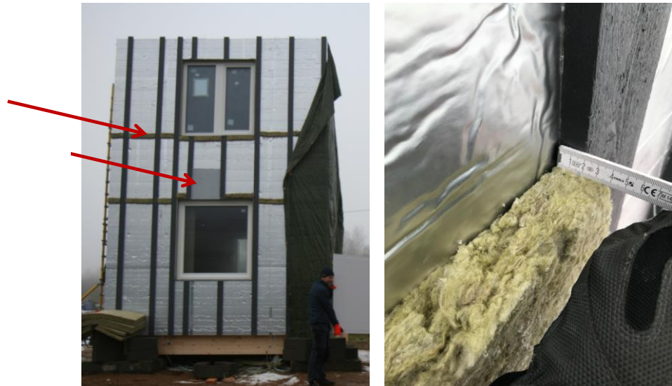
Joonis 4. Kivivillast tuletõkestid ehituse ajal
