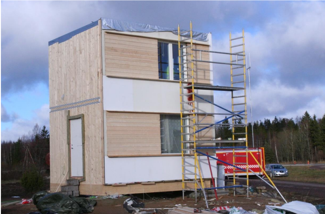
Joonis 5. Katsehoone kombineeritud fassaad puitlaudise ja tsementplaatidega
