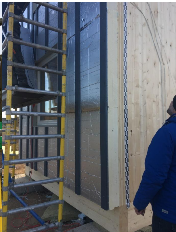
Joonis 13. PIR fassaad
