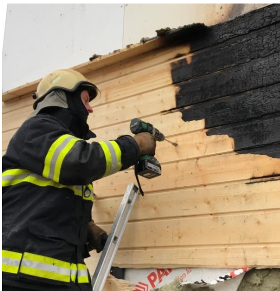
Joonis 31. Augu puurimine fassaadilaudisesse
