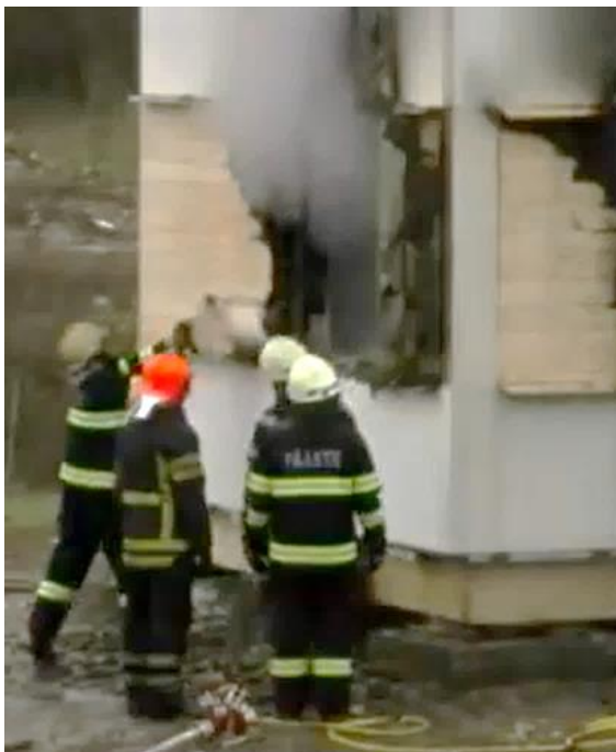
Joonis 29. Elementide lõhkumine, et pääseda tulekoldele ligi
