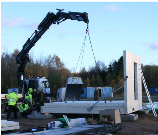
Joonis 8. Esimese korruse põrandaplaadi paigaldus
